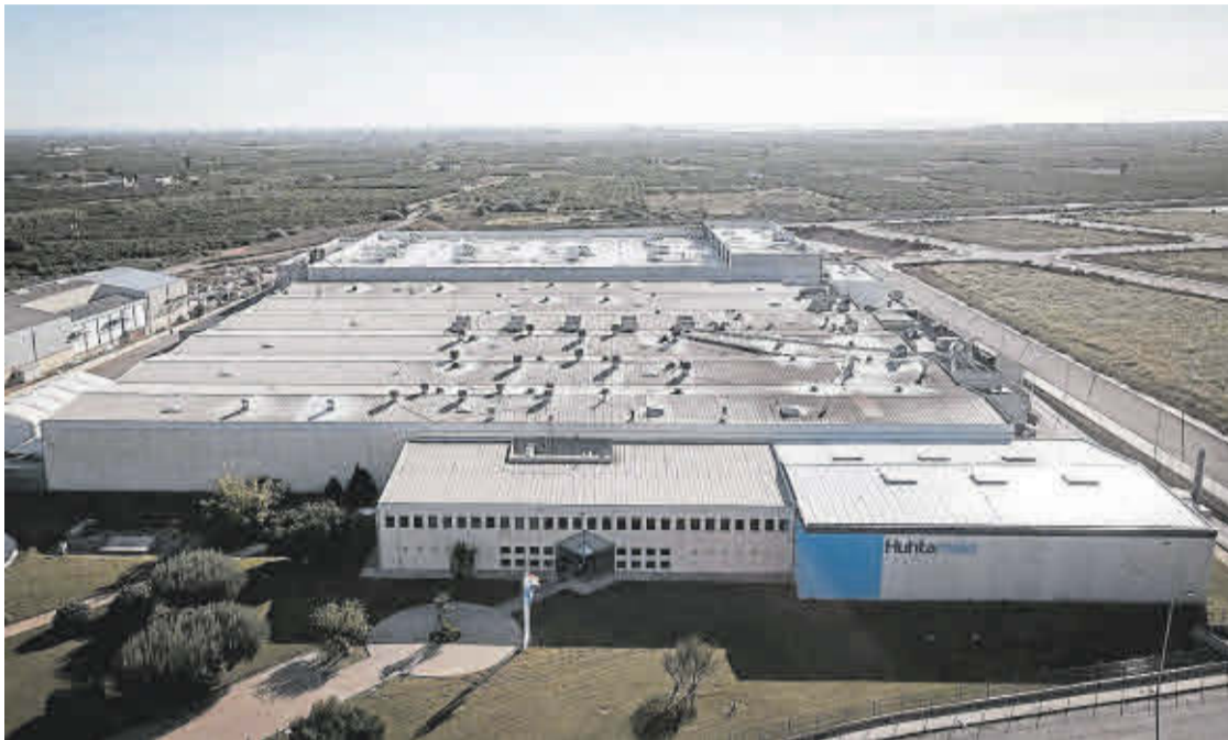
Exterior de las instalaciones con las que cuenta Huhtamaki en la localidad de Nules.
