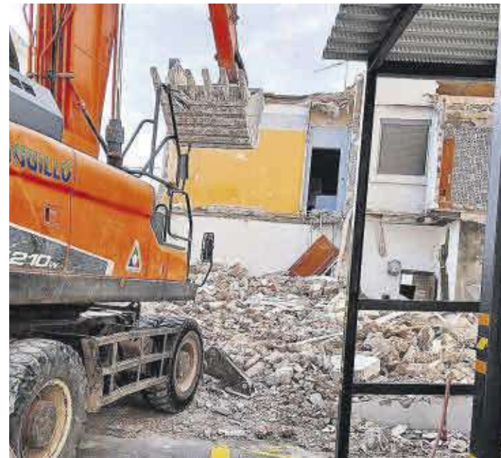
Treballs de demolició de l'habitatge situat al carrer de Ramón Llull.
