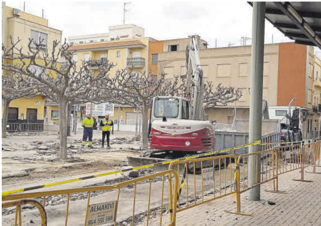
La millora de la plaça de Fra Asensi Nebot és una de les obres previstes en el pressupost de 2025 que ja ha començat.
