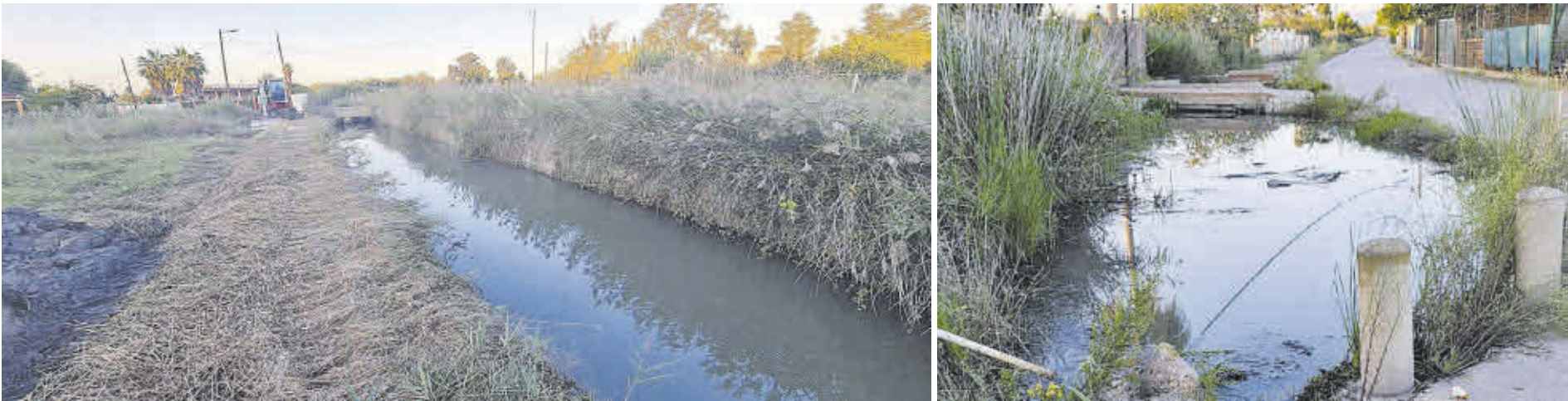
El Ayuntamiento de Nules ya ha iniciado los trabajos de limpieza de acequias y cauces en diversas zonas del término municipal que se desarrollarán durante los meses de julio y agosto.
