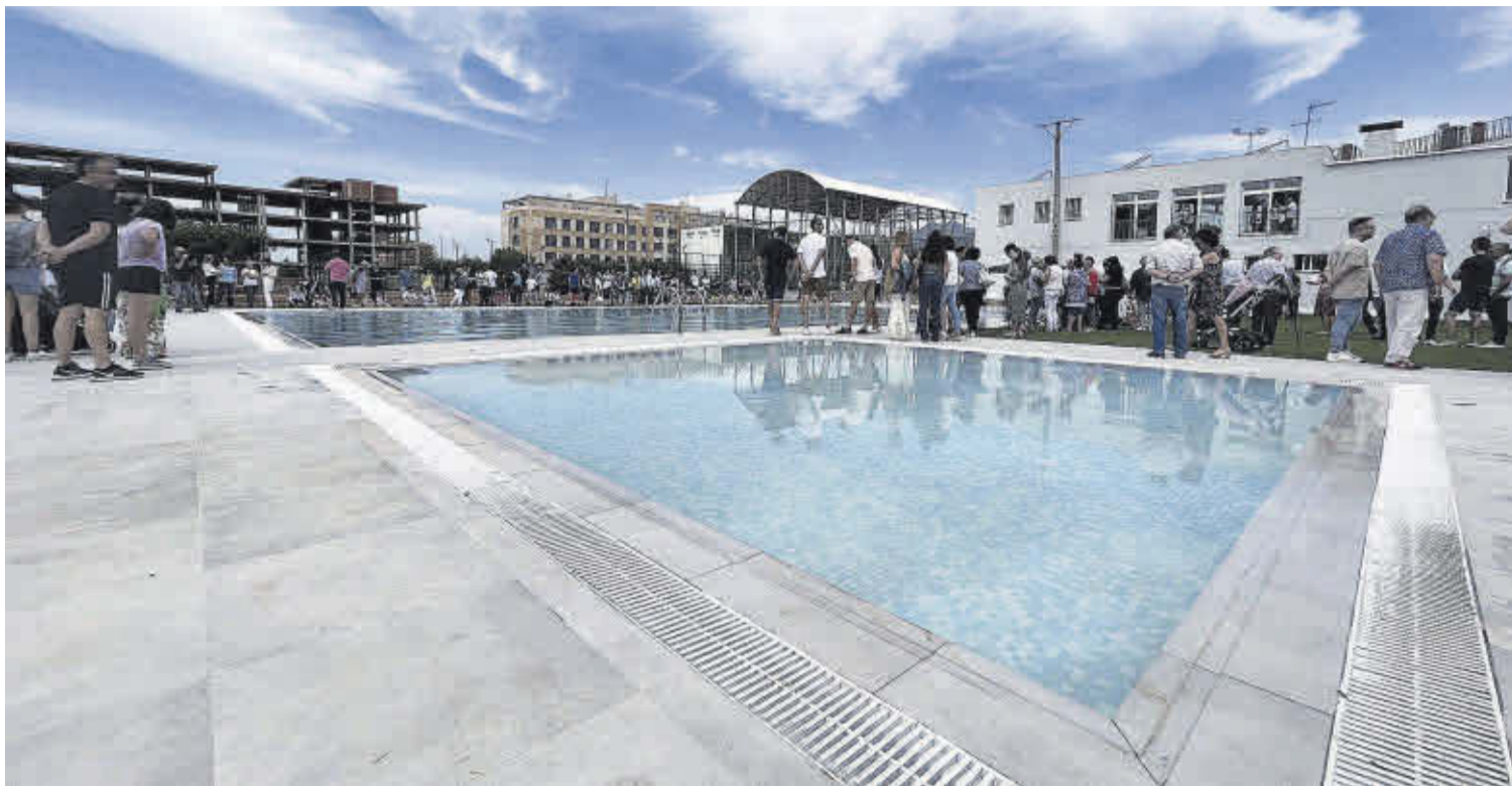
Un gran nombre de veïns i veïnes es van apropar a les instal·lacions d'Scude per a conèixer la nova piscina descoberta el dia de la seua inauguració.
