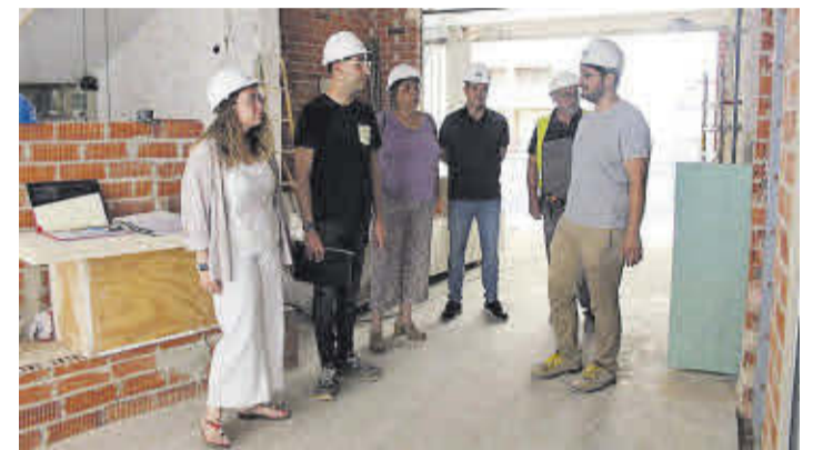
Les regidores Blanca Silvestre i Rosa Ventura, durant la visita a les obres.
