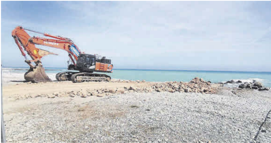
La maquinària pesada ja està treballant en la zona en la que es construiran quatre espigons a les platges de Nules.
