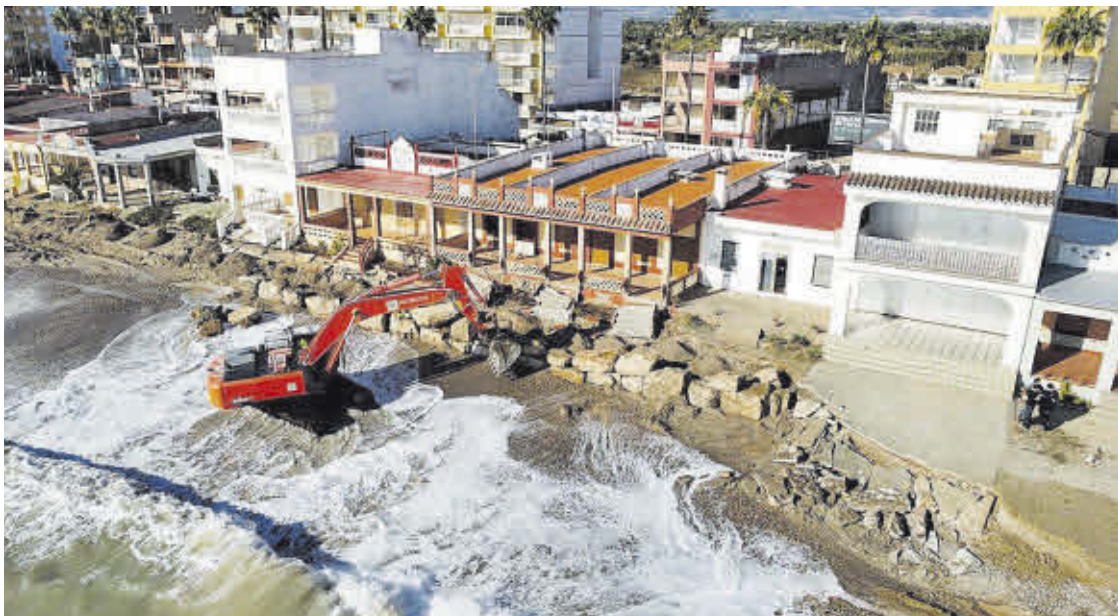
L'empresa contractada per l'Ajuntament va començar a construir el mur a la platja del Bovalar el dissabte 13 de novembre.
