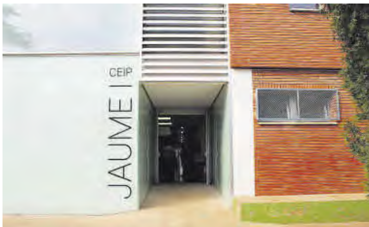
Les millores del CEIP Jaume I són visibles ja des de l'exterior de l'edifici.
