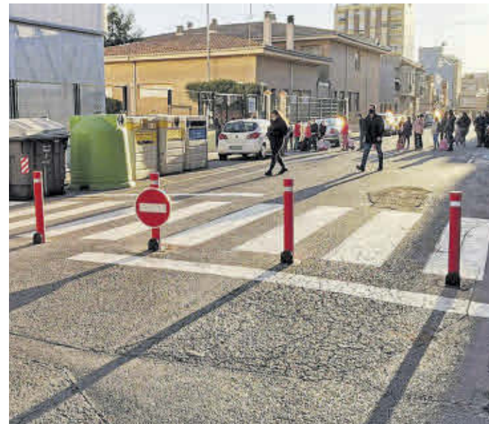
Els primers pilars es van instal·lar a la zona del CEIP Pío XII.
