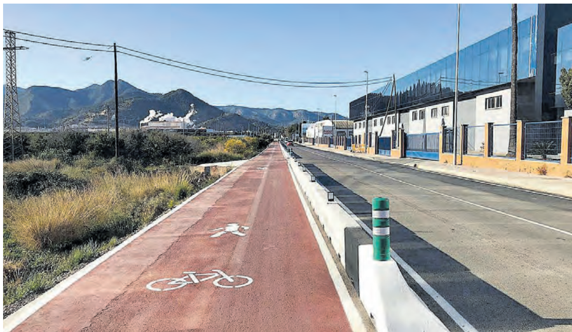
Les obres que s'executaran en l'entorn d'Stylnul permetran millorar el carril bici de la carretera Vilavella-Nules.
