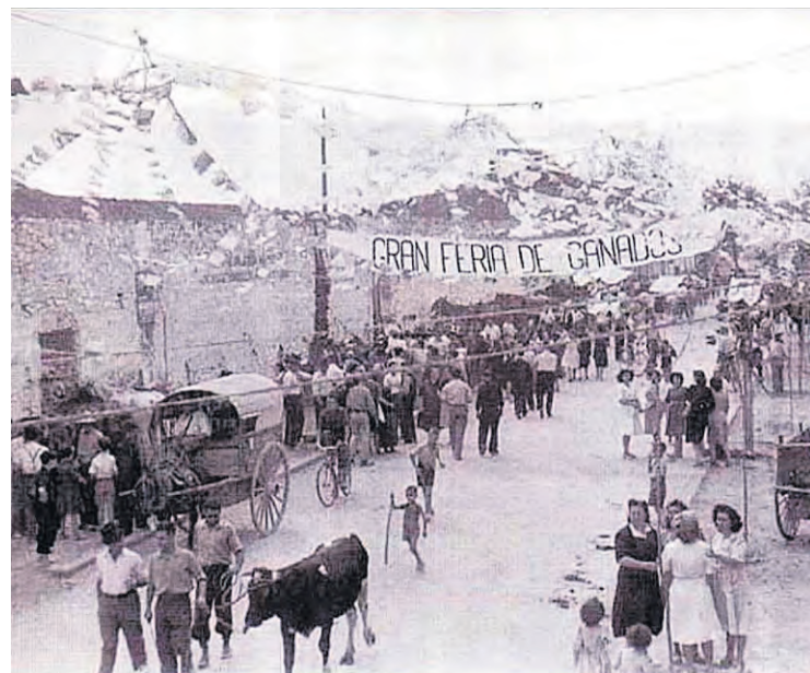
1947. Primera Fira en l'actual avinguda de la Constitució.
