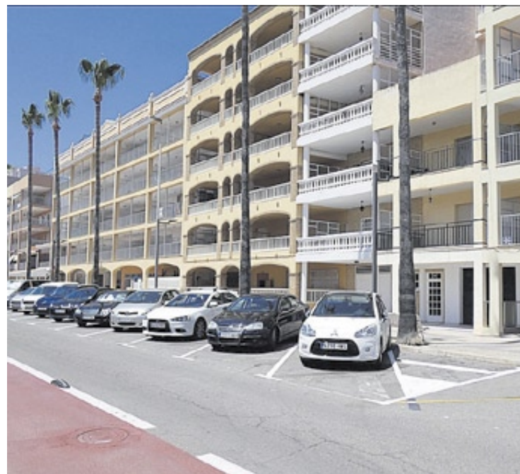
Els vehicles ja aparcuen en espiga a la primera línia de les platges.
