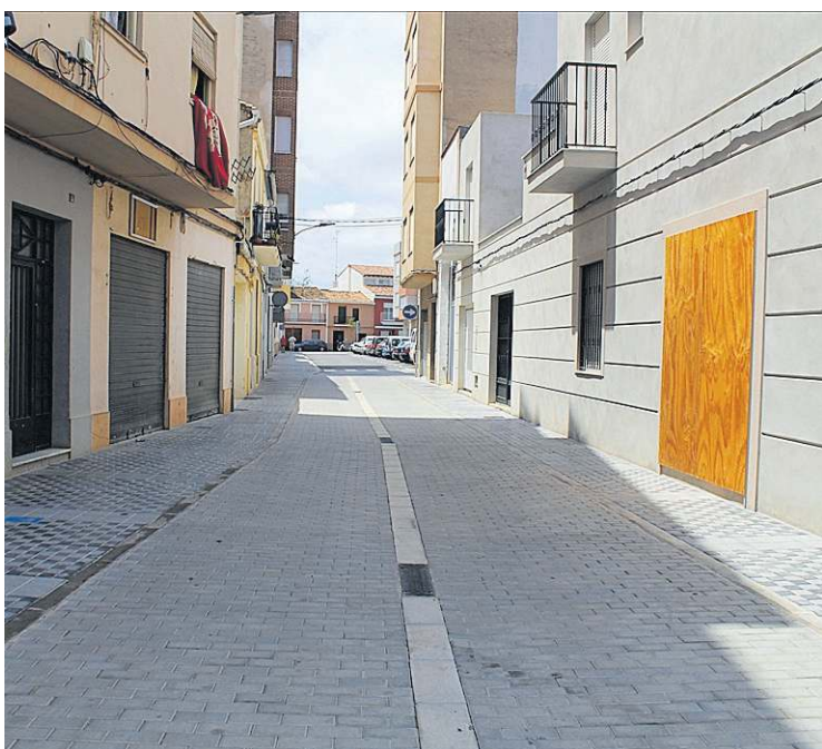
Els treballs de remodelació ja han acabar al carrer de l'Assutzena.
