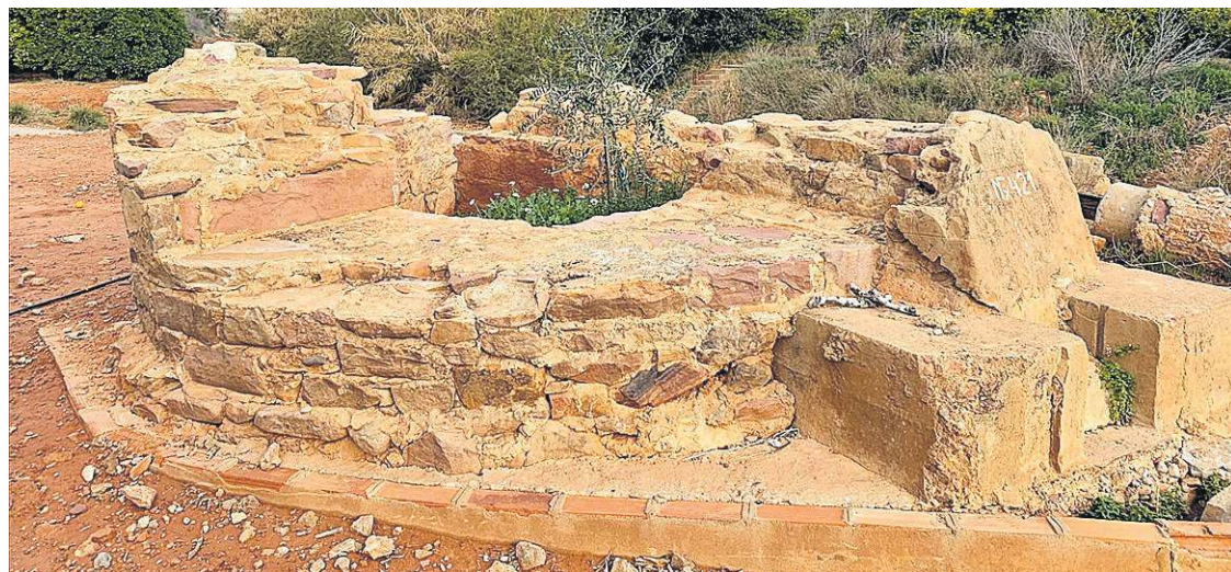
■ TREBALLEN A DOCUMENTAR ELS BLOCAUS PER A LA SEUA RESTAURACIÓ I PRESERVACIÓ
