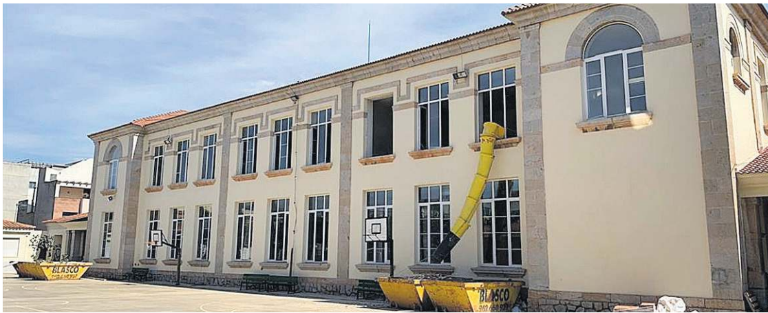
L'edifici principal del CEIP Cervantes ja està sent objecte de diverses millores a càrrec del Pla Edificant.
